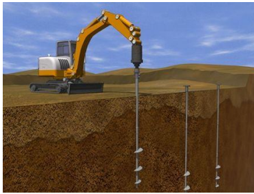
Рис. 13. Монтаж винтовых свай
