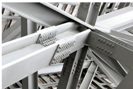
Рис. 36. Стык балок и колонн
