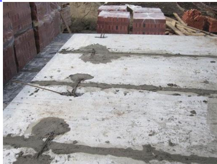
Рис. 38. Заделка швов между плитами перекрытия
